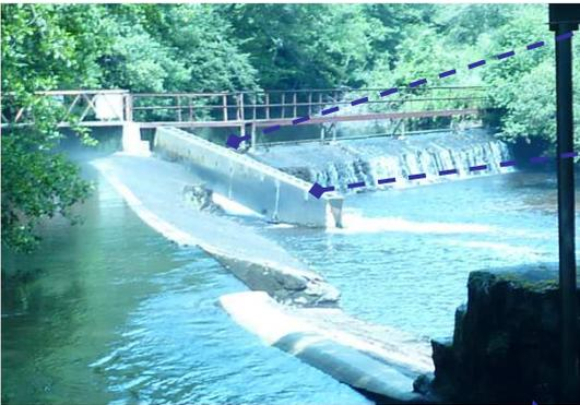
Echancrure du barrage avec un débit de  $0,950\text{m}^3/\text{s}$  destiné au débit d'appel pour l'échelle à poissons.
