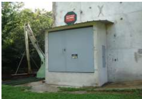
Le transformateur accolé au mur de la centrale
